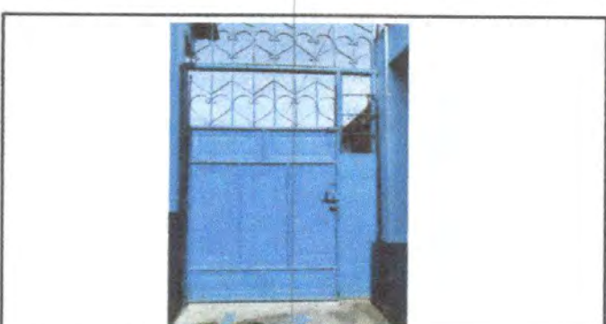
Foto 6: Sustrucción porton de emtal
