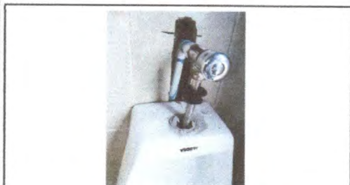
Foto 3: Sustrucción de mingitorio
