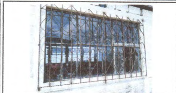
Foto 1: Sustrucción de balcon de metal
