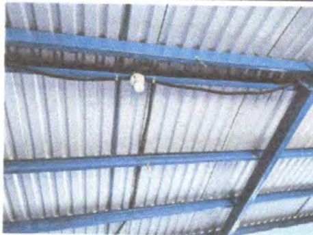
Foto 3: Sustitución lamparas led
