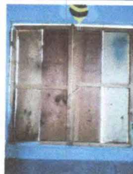
Foto 2: Sustrución de estructura de metal por PVC
