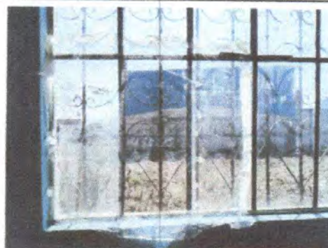
Foto 4: Sustrución de estructura de metal por PVC
