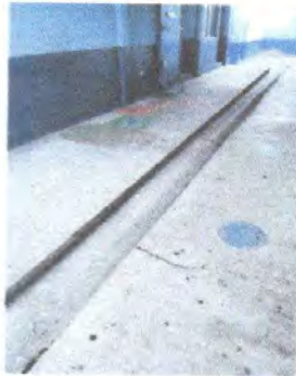
Foto1: Reparación de plancha de concreto de patio
