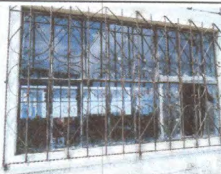
Foto 6: Sustrución balcon de metal
