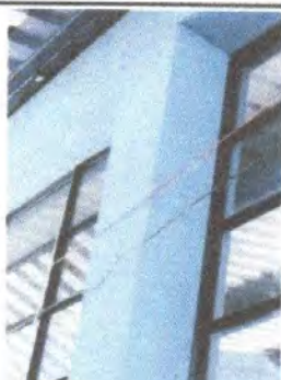
Foto 5: Reparación cableado electrico
